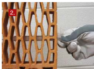
2. Установить в просверленное отверстие соответствующую сетчатую гильзу.
